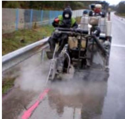
Las Micro zanjas constituyen una novedosa técnica constructiva de redes ópticas en entornos urbanos. Consiste en la instalación de cables y microductos en el interior de cortes de pequeñas dimensiones realizados en asfalto u hormigón. Sus dimensiones aproximadas son de 15-20 mm de anchura y 8-20 cm. de profundidad.
